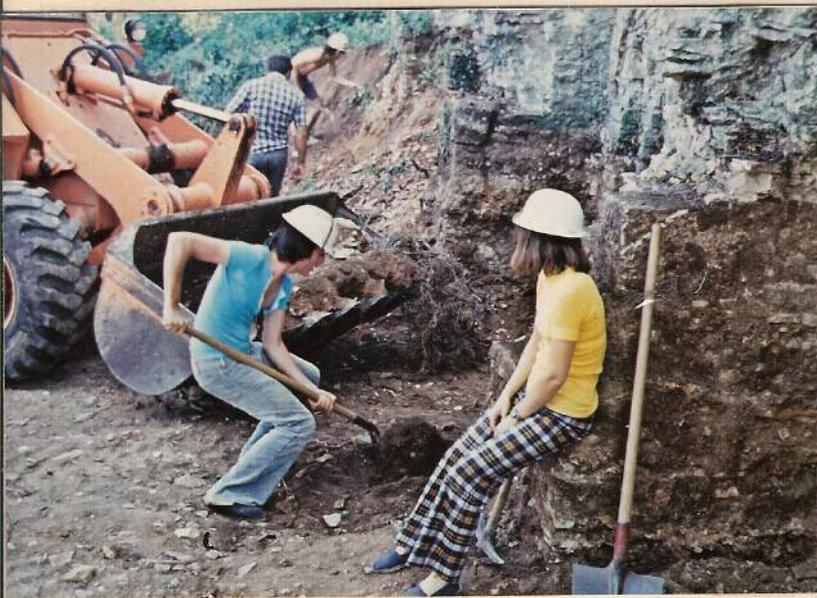
1973- 250m<sup>3</sup> évacués, a la pelle, pioche et aide par de puissants engins vu l'importance des débris accumulés.
